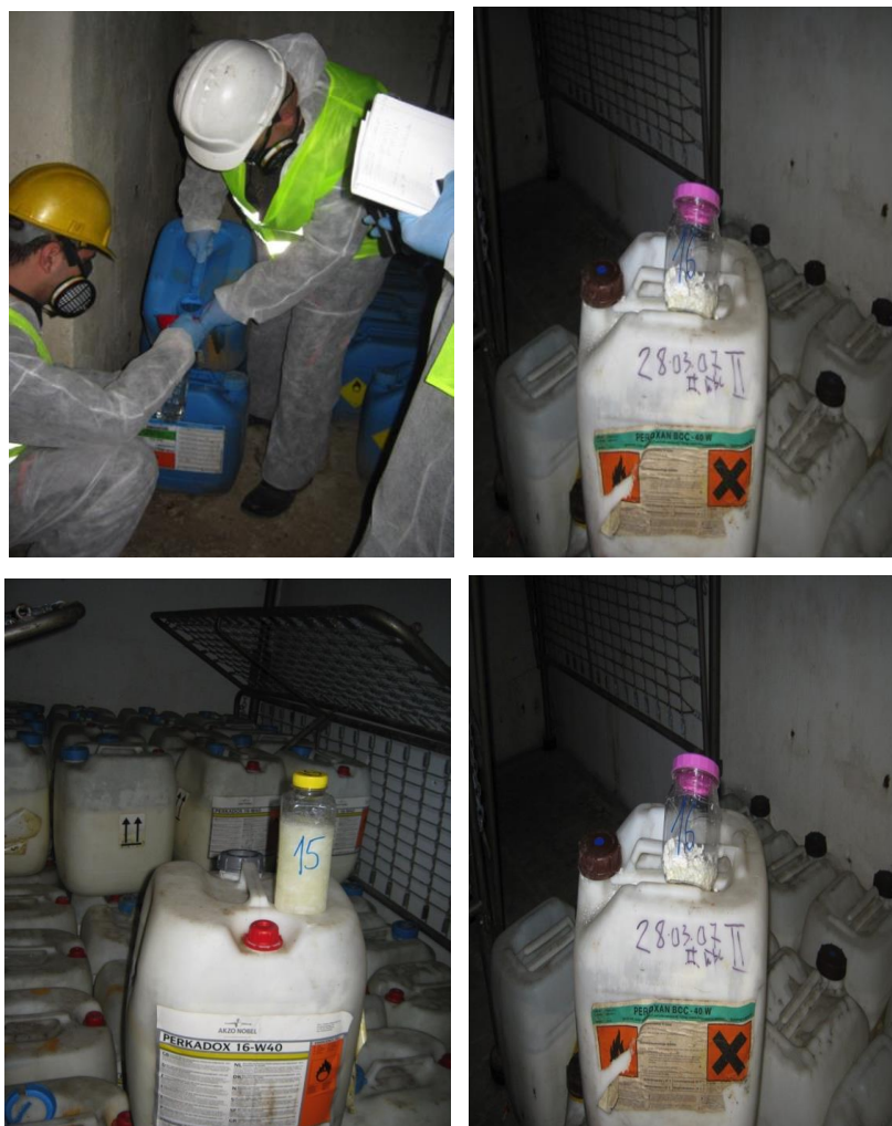
Слика 17 Земање на примероци од иницијатори: PEROXAN BCC -40W, PERKADOX 16-W40, BUTYL HYDRO PEROXID 70%
